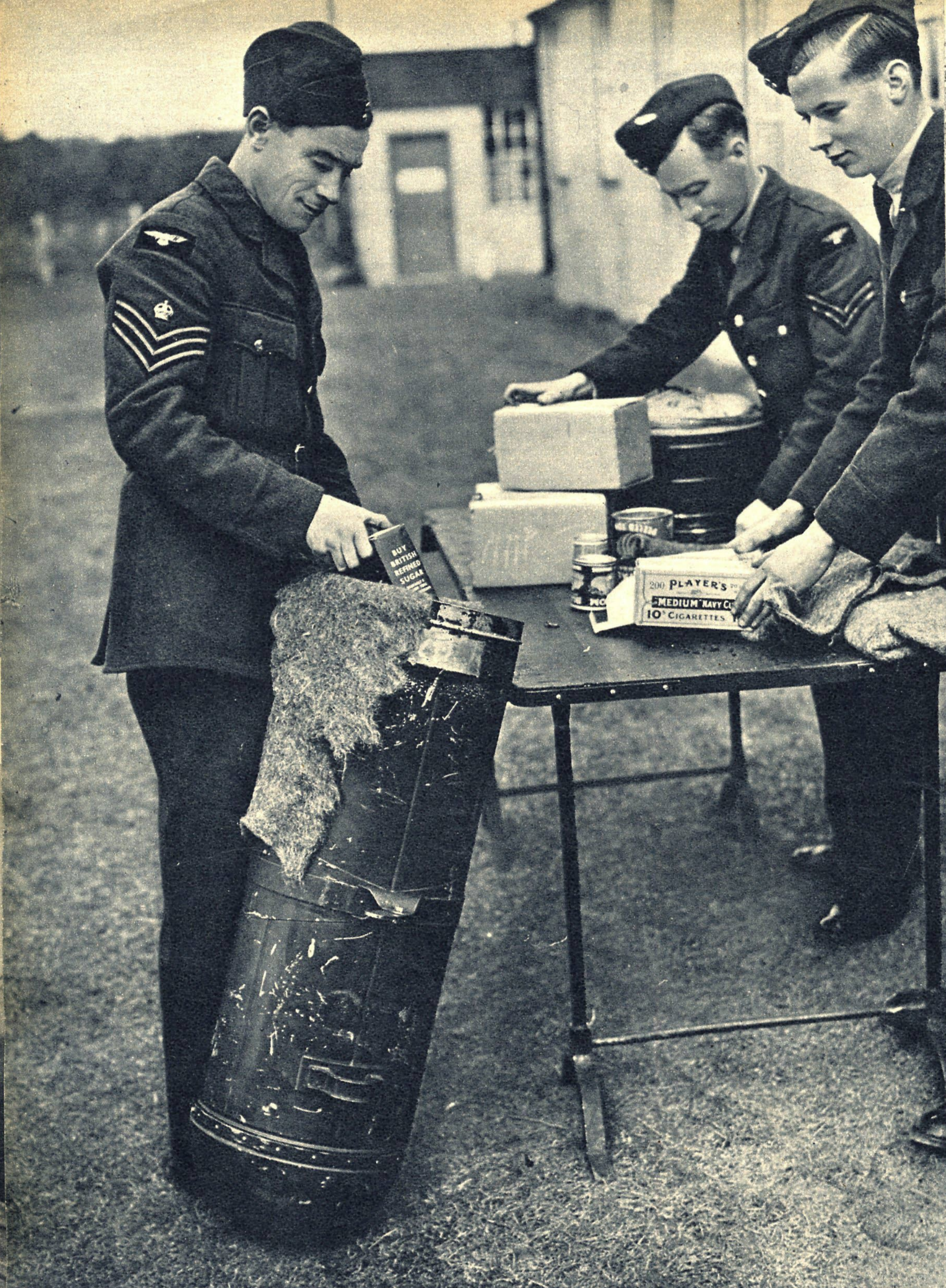
Die „Bombe“ wird mit allerlei Lebensmitteln „geladen“. Dabei muß sorgfältig auf richtige Gewichtslagerung geachtet werden.
